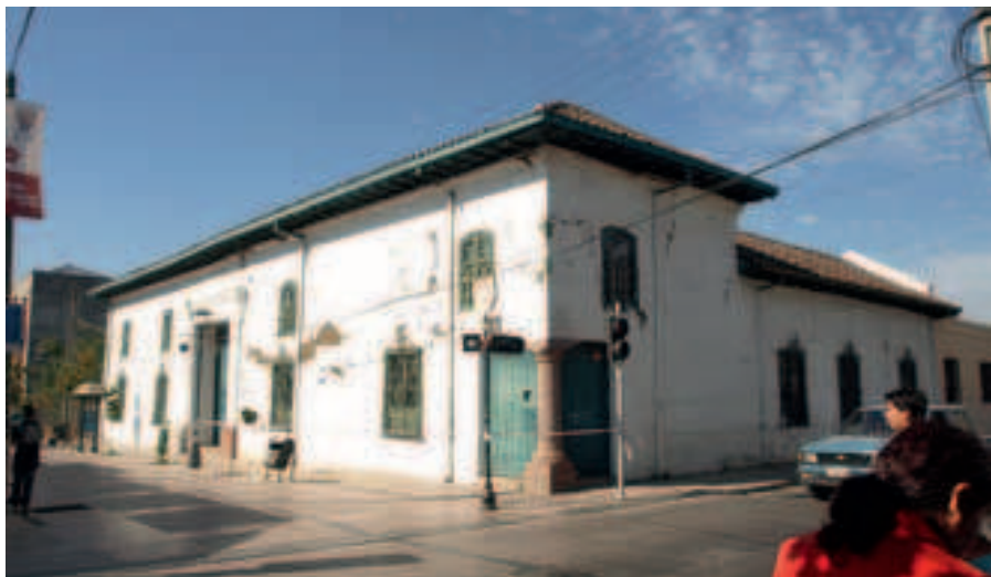
Foto 9: Vista exterior de la Casa del Pilar de Esquina de Rancagua.
