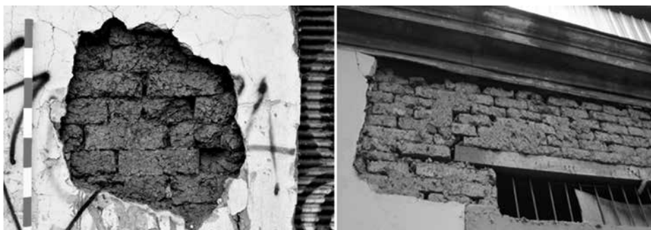
Figura 8: Presencia de la albañilería de adobe en los muros de fachada de las viviendas de Matta Sur. Fuente: (Rojas, 2016).
