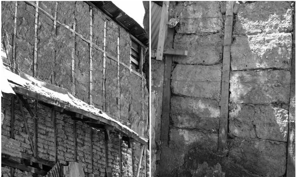
Figura 5: (Izquierda) Ejemplo de muro medianero de una vivienda con tabique de madera relleno con adobe en sogá en el segundo nivel y en pandereta en el tercer nivel. (Derecha) Muro divisorio interior con bloques de adobe dispuestos en pandereta y sujetos a los tabiques por medio de alambres. Fuente: Fotografía de la autora.
