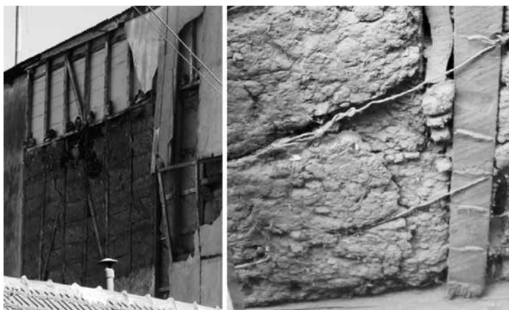
Figura 9: Presencia del tabique de madera relleno con adobe en pandereta en un segundo piso de una vivienda (a la izquierda) y en un muro divisorio interior (a la derecha). Fuente: (Rojas, 2016).
