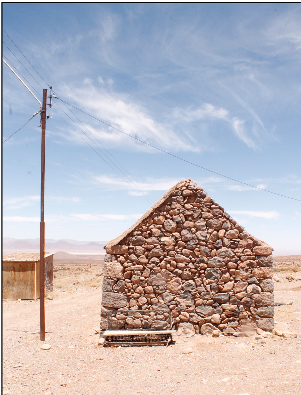
Figura 4. Vivienda tradicional likan antai de Cupo, construida con mampostería de piedra. Fuente: Autores.
