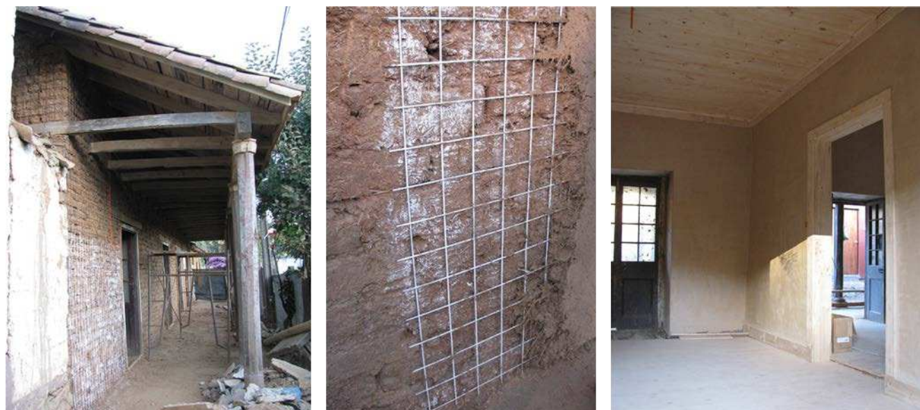
Figura 5. Aplicación de malla electrosoldada como refuerzo en muros de adobe. Recuperación de viviendas en Vichuquén. Fuente: Claudia Torres.
