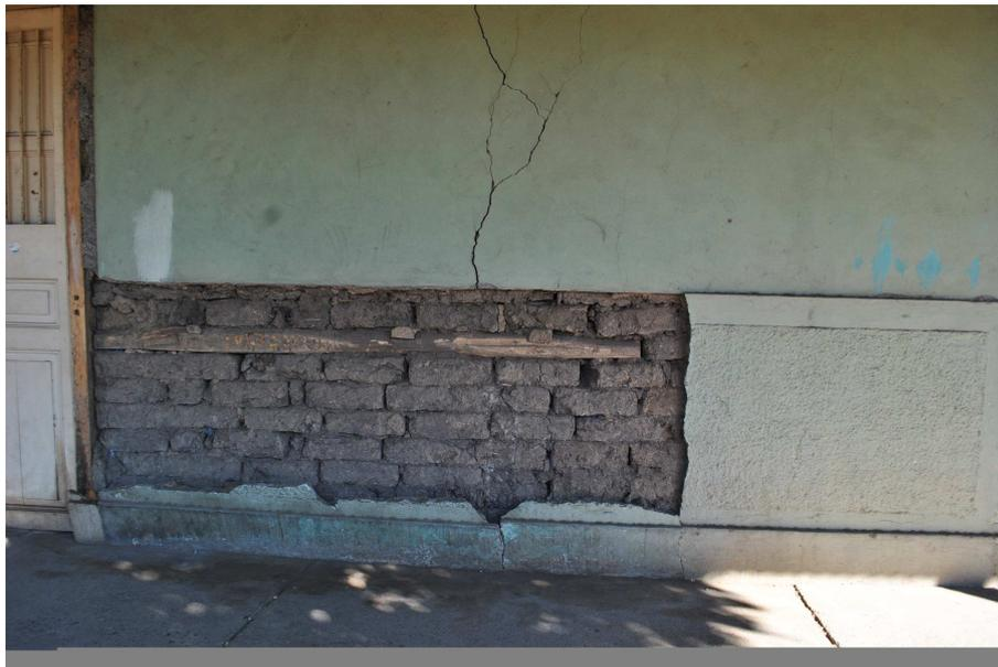
Imagen 3. Detalle de vivienda en Guacarhue, VI Región, donde se aprecian las llaves de madera que complementan el desempeño de la estructura de adobe. (Fotografía de la autora).
